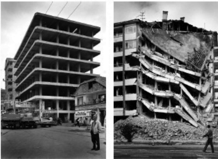
Figura 1.1: Effetti del terremoto di Gölcük su strutture simili a telaio: nuda (sx) e tamponata (dx).
