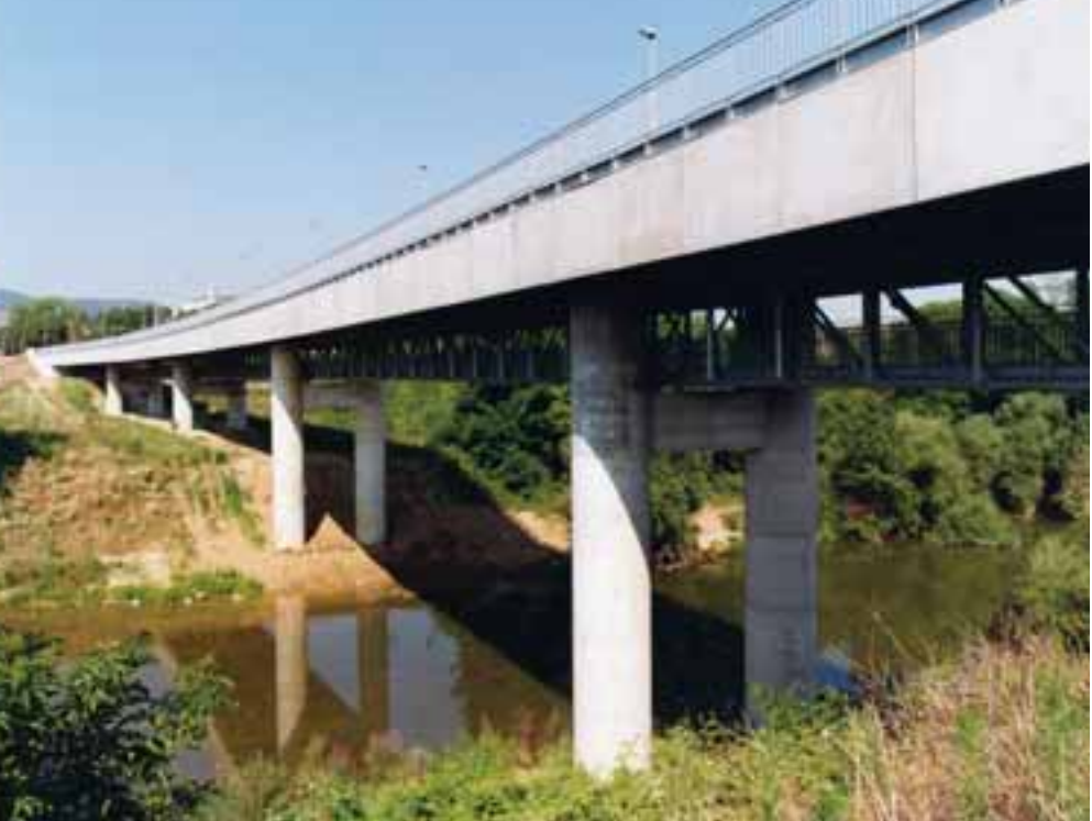
U. CAO, M. DEL VECCHIO, G. MARRUCCI, C. MULLER VIADOTTO SUL FIUME LIRI A PONTECORVO
