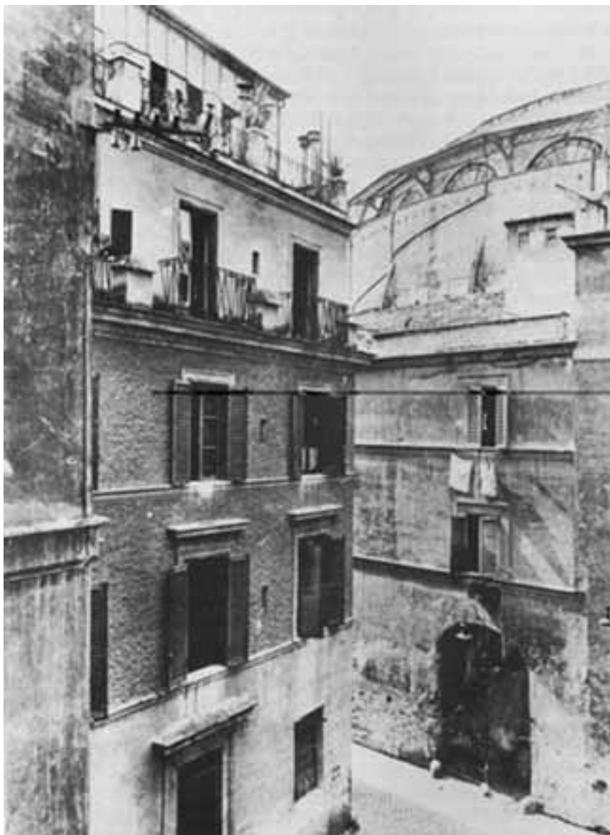
3. Il Teatro - Auditorium Augusteo in una foto precedente la sua demolizione
