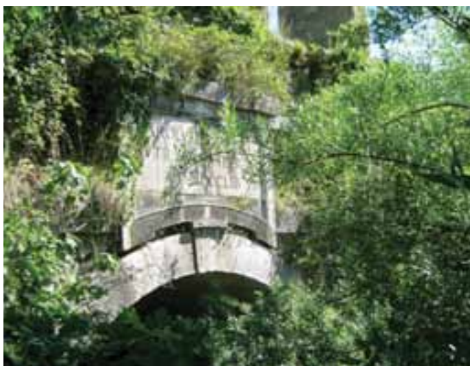
Particolare del ponte sul Faenza. Iscrizione del Vanvitelli.
