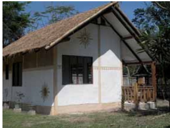
Modulo abitativo a Vientiane (Laos) in corso di realizzazione e ultimato.
