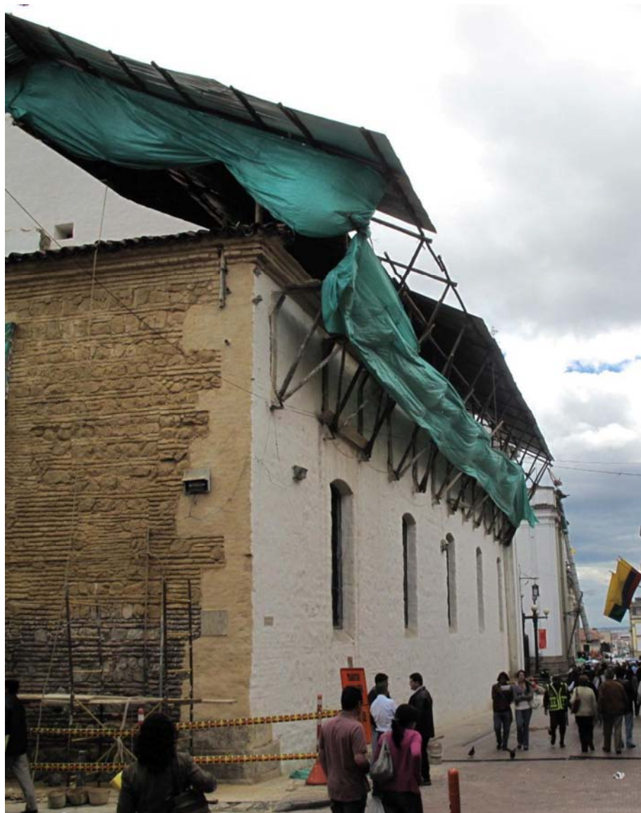
Obra de restauración en que se aprecia la reposición de pañetes en el actual Museo Colonial de Bogotá, (antigua capilla de los indios año de 1604) que después de las tendencias en restauración en Colombia en los años sesentas, estos habían sido retirados. Bien de Interés Cultural (Foto: Rubén Hernández Molina, Bogotá 2011).
