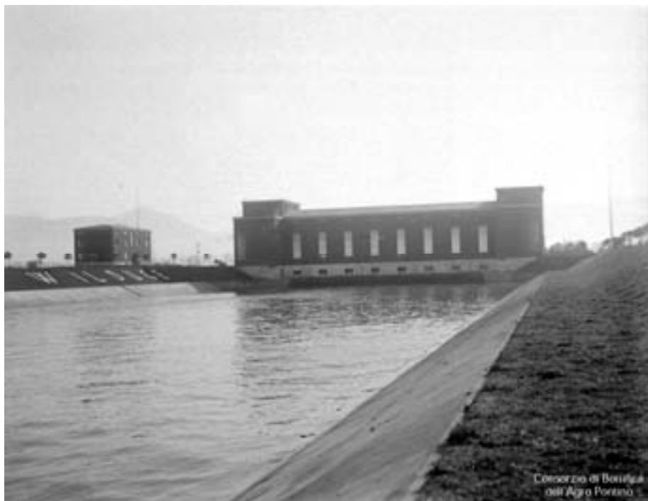
fig. 3 Impianto idrovoro di Mazzocchio (1934)
