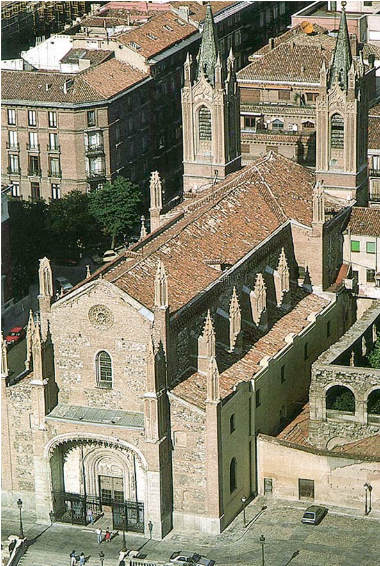
Figura 2: Madrid. Visione dall'alto del complesso della chiesa e del chiostro di San Jerónimo prima dell'intervento.
