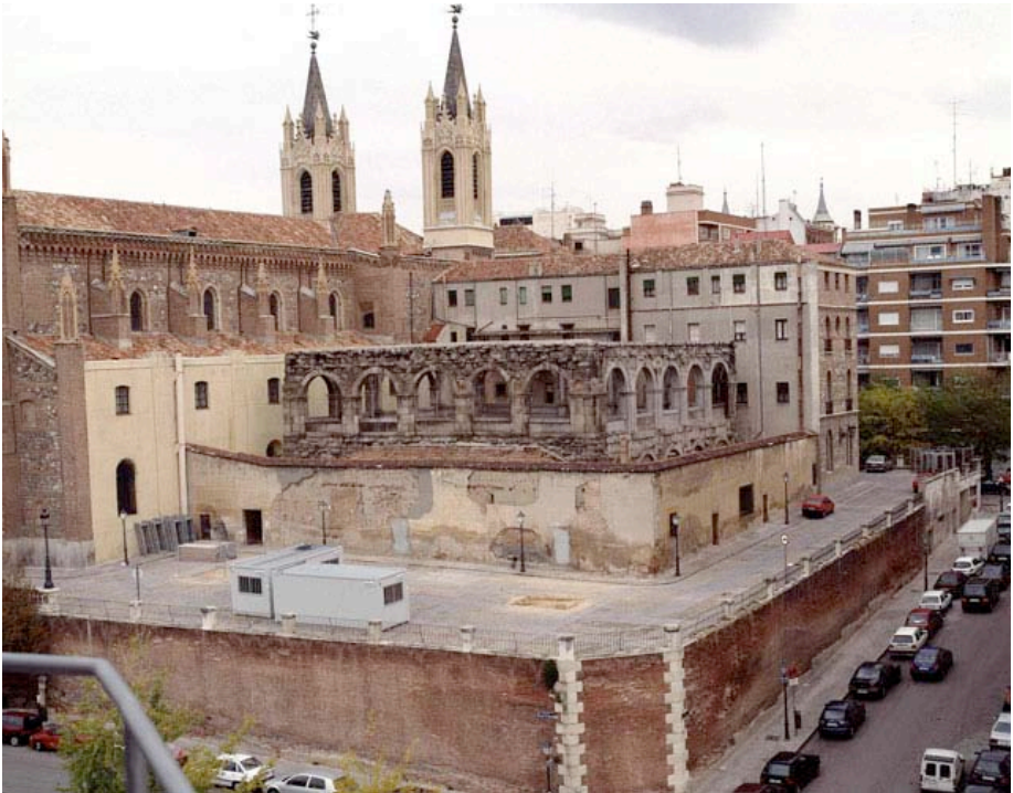
Figura 1: Madrid. Il chiostro di San Jerònimo del XVI secolo, prima dell'intervento.
