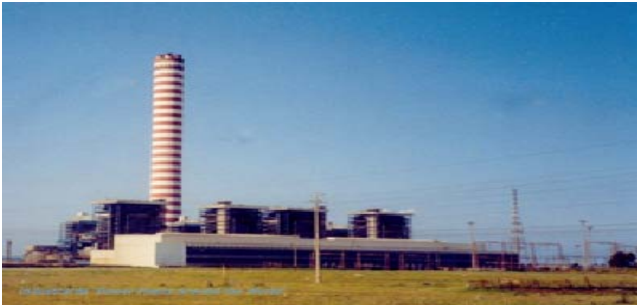
Impianto di Torrevaldaliga Nord.
